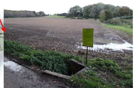
GD-B1 amont rue du Moulin
